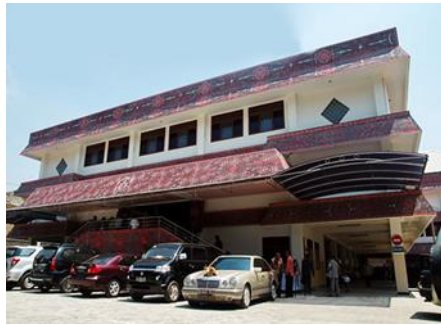
Gambar 4. BPU Ruma Gorga Mangampu Tua 3 Sumber: Dokumen Pribadi, 2020
