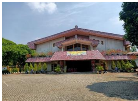
Gambar 3. BPU Ruma Gorga Mangampu Tua 2 Sumber: Dokumen Pribadi, 2020
