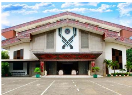
Gambar 2. BPU Ruma Gorga Mangampu Tua 1 Sumber: Dokumen Pribadi, 2020
