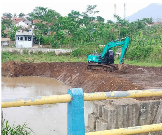
Gambar 4. Pengerukan Sediment Trap Sungai Cikeruh
